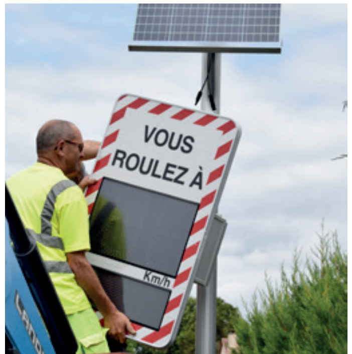
Installation du radar
